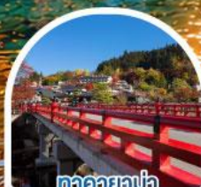
ทิวคาวาฟุจิ สะพานนากะบาชิ
